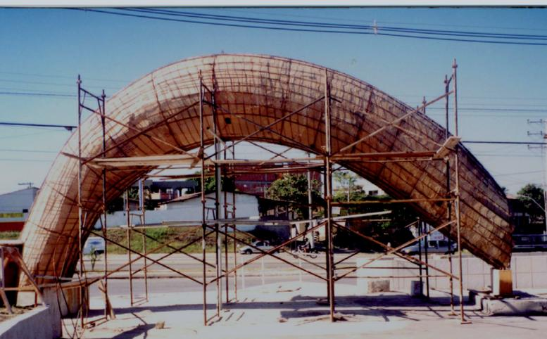
Etapa do processo de uma modelagem com argamassa estruturada em grande escala.
