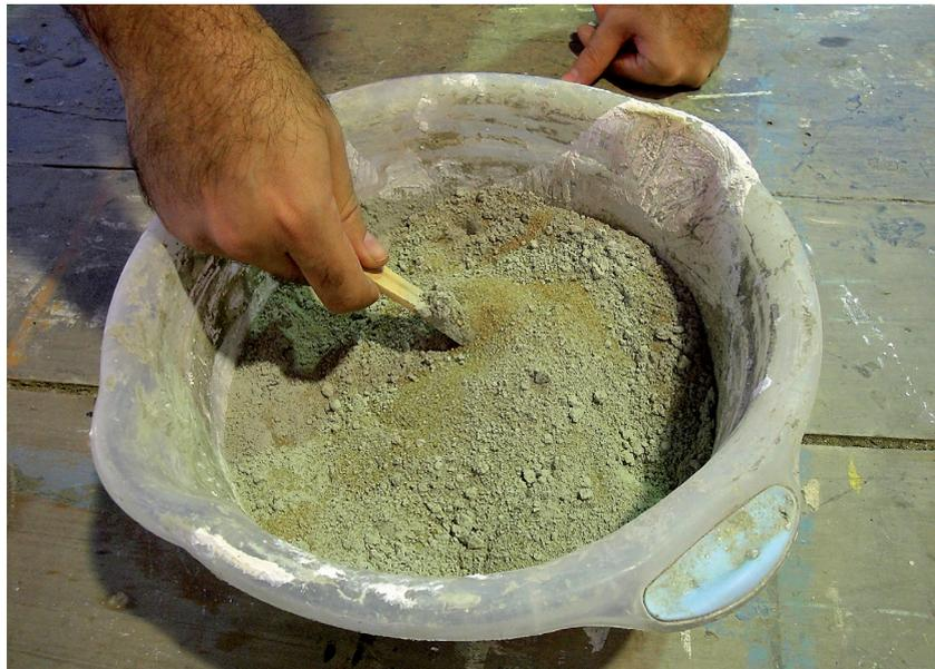
Prepare separadamente os materiais, misturando-os posteriormente e adicionando-lhes água até um ponto de consistência que não seja muito mole e nem muito seca. O ponto desta argamassa deve ser bem duro, mas não ao ponto de esfarelamento.
