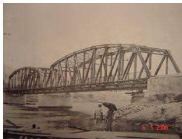
Figura 9 Ponte Florentino Avidos (1928)
