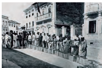
Figura 11 Abastecimento de água em chafariz em Vitória (1905)
